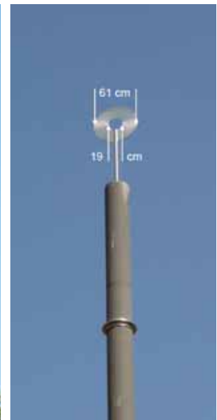
Abb.4 Die Lochscheibe auf dem Nordmast.
